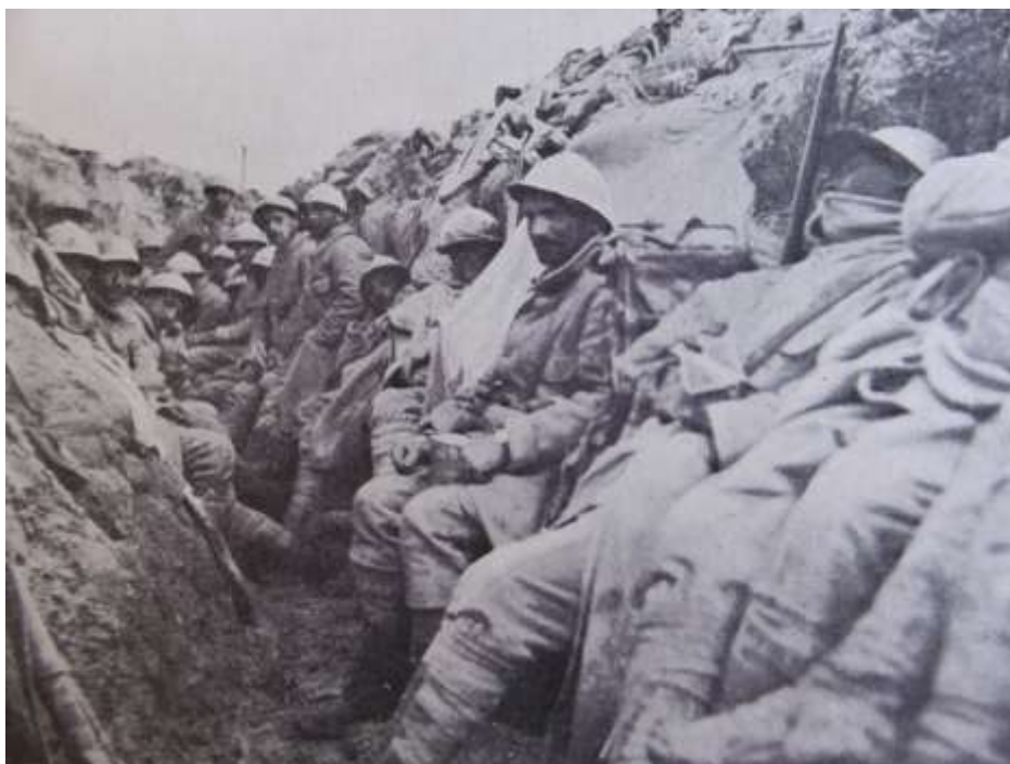
Dans une tranchée avant l'assaut
