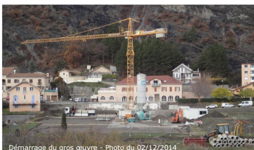
Démarrage du gros œuvre - Photo du 02/12/2014
