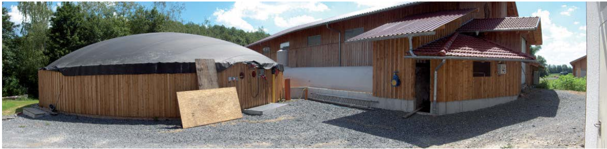
Exemple d'installation existante.
